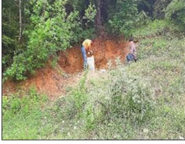
Fotoğraf 1, 2, 3: Toprağın yerinden çıkarılması; Çıkarılan toprağın elenerek temizlenmesi, su geçirmez düz zemine alınan toprağa su verilmesi.
