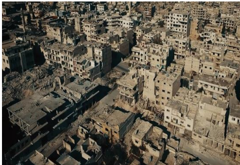
Görsel 17: Yıkılan ve Sağlam Kalan Evler
