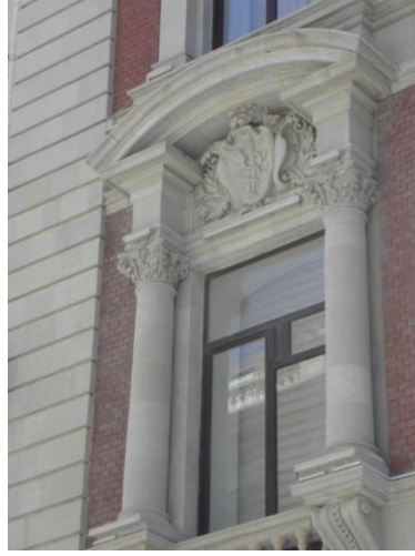
Fotoğraf: 2 Bakü Belediye Binası Giriş Cephesinde Yer Alan Pencerelelerden.
